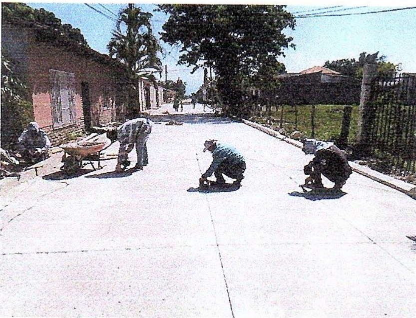
18. Sello de junta asfáltica en calle #4.
