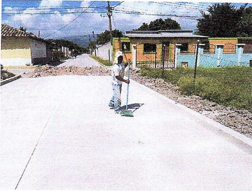
18. Sello de junta asfáltica en calle #4.
