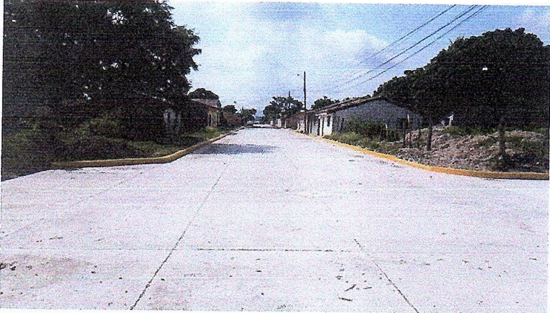
3.2 calle # 1 pavimentada con concreto hidráulico
