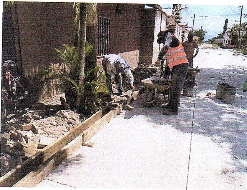
16. Bordillo de concreto de 15x15 cms en calle #4.
