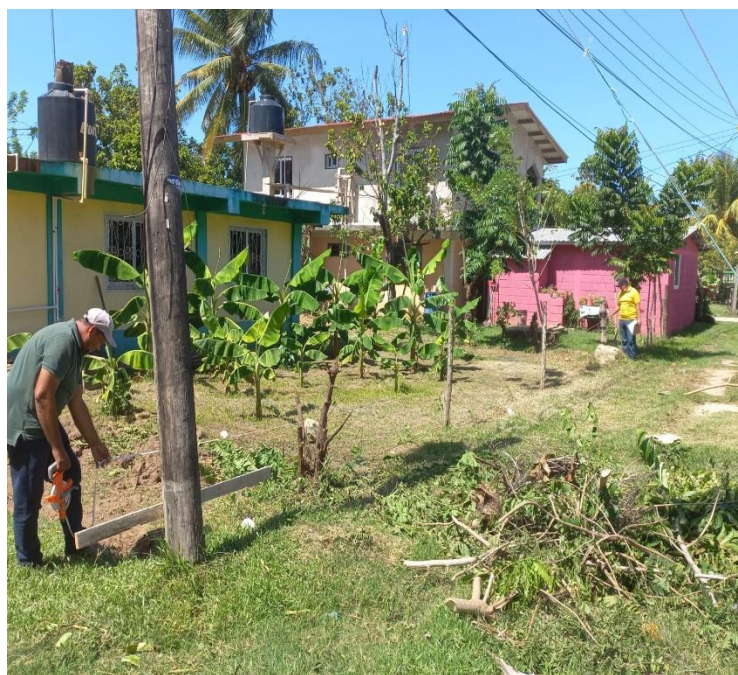
Medición colonia miramonte, para la construcción de cerco.
