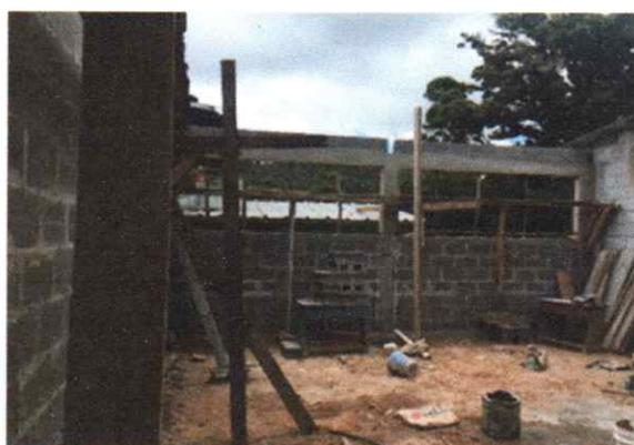
Colocación de canaletas de 2x4 espaciada de acuerdo con las especificaciones de planos se fundió con concreto, se finalizó con la instalación de laminas de alucín e instalación de aislante térmico en el interior.
