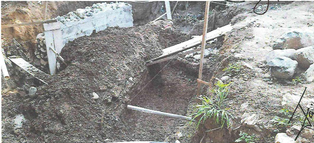
Excavación para la construcción del segundo estribo de mampostería de la caja puente, barrio El Campo, Los Tangos.
