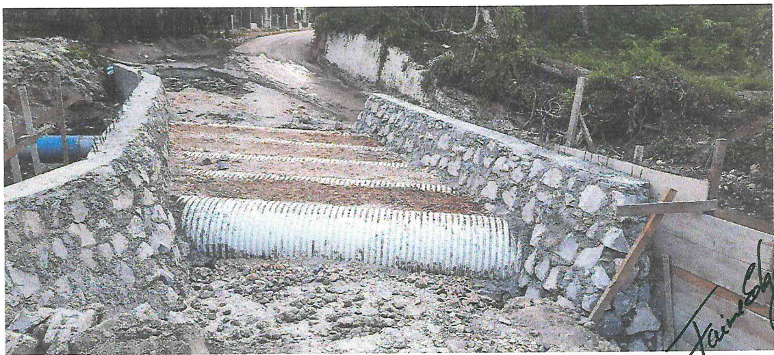
Durante la colocación del relleno con material selecto compactado – vado mixto sobre la quebrada Santa Luz – se observa que ya fueron contruidos los muros de cabeza y de pie.
