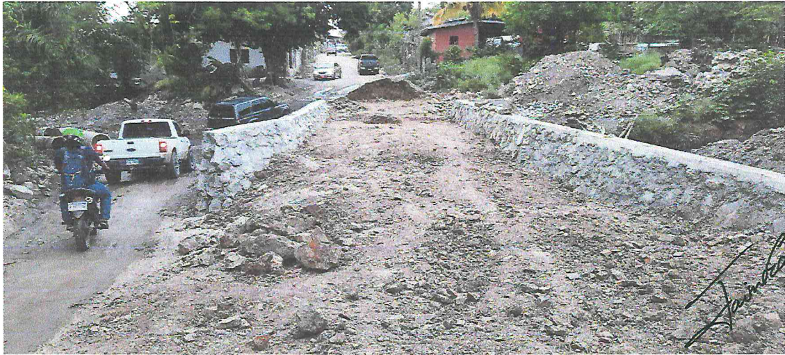
Durante la colocación del material selecto compactado una vez finalizados los muros de pie y de cabeza - vado mixto sobre la quebrada Santa Luz.
