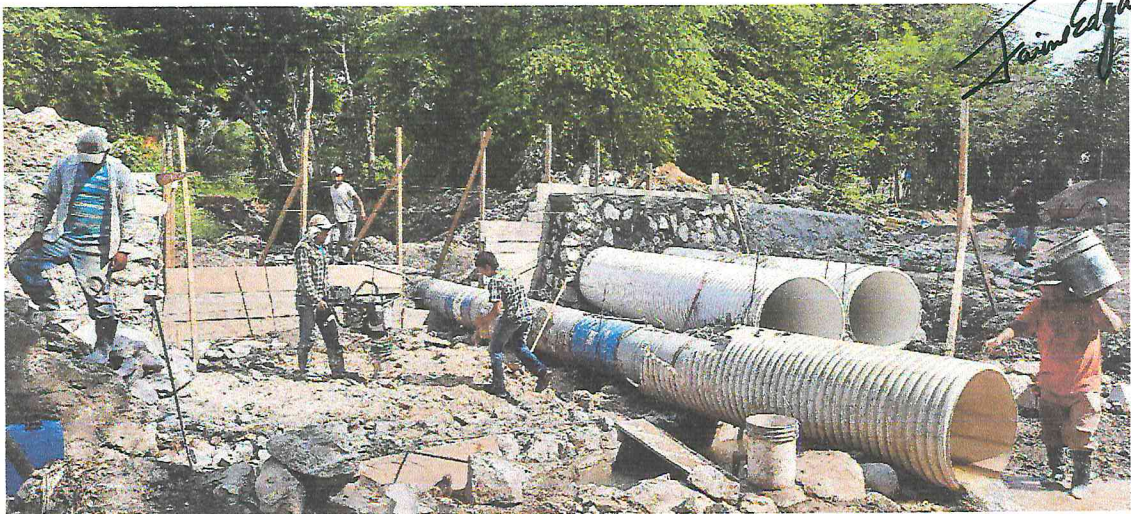
Durante la instalación de las tuberías de PVC helicoidal de 36" y la construcción del muro de cabeza de mampostería – vado mixto sobre la quebrada Santa Luz.
