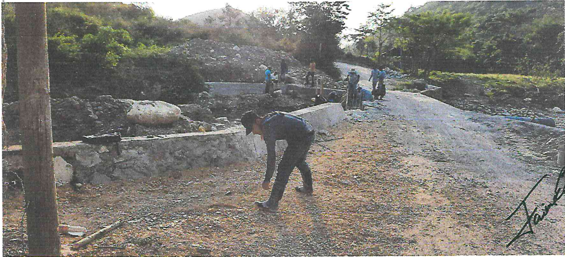
Muro de contención del ala Sur-Oeste una vez finalizado, se observa que se realizó el relleno de ese sector de la aproximación sur.
