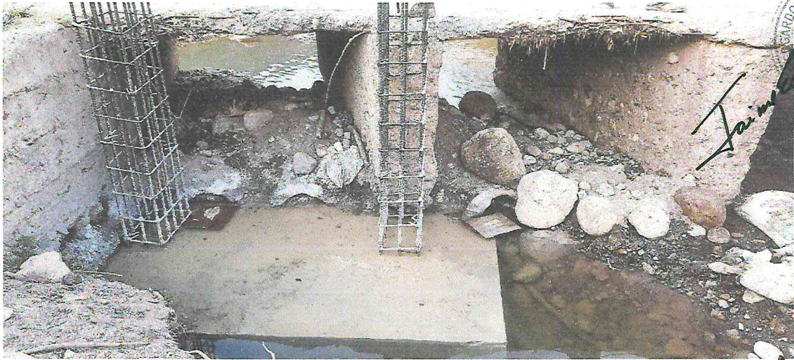
Zapatas aisladas fundidas – caja puente sobre la quebrada Saisoque.
