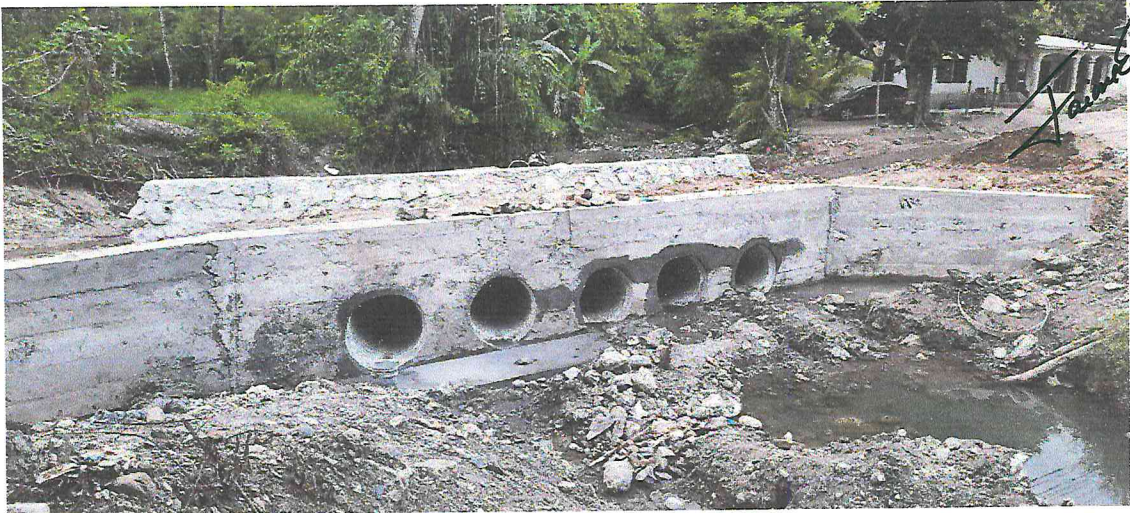
Vista frontal del vado mixto una vez contruidos los muros de cabeza con sus respectivas alas, el enchape y dentellón de entrada, muro de pie y parte de las alas del mismo - vado mixto sobre la quebrada Santa Luz.
