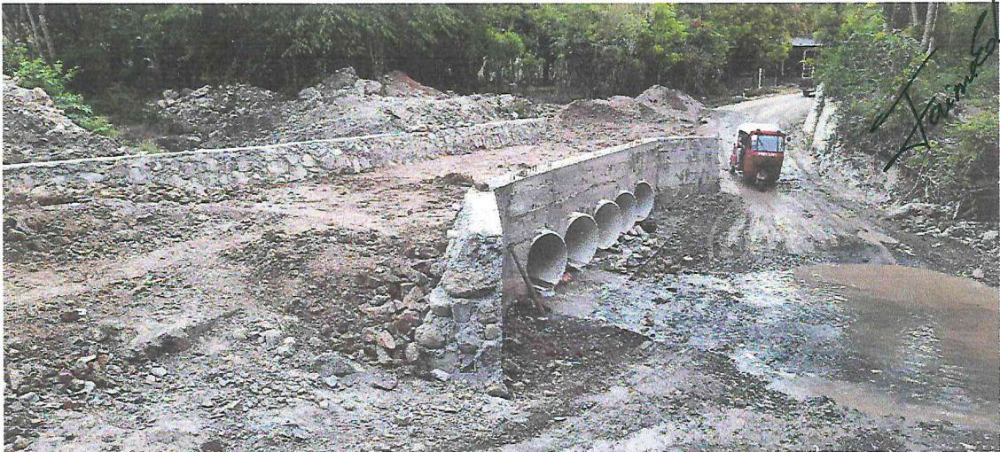
Perspectiva del muro de pie, se observa que ya fueron instaladas todas las alcantarillas de PVC helicoidal de 36" y se construyó el enchape y dentellón en la salida - vado mixto sobre la quebrada Santa Luz.
