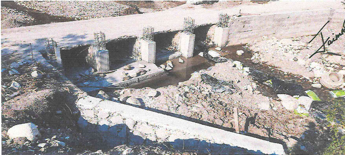
Muro de contención construido lado Nor-oeste – ala de caja puente sobre quebrada Saisoque.
