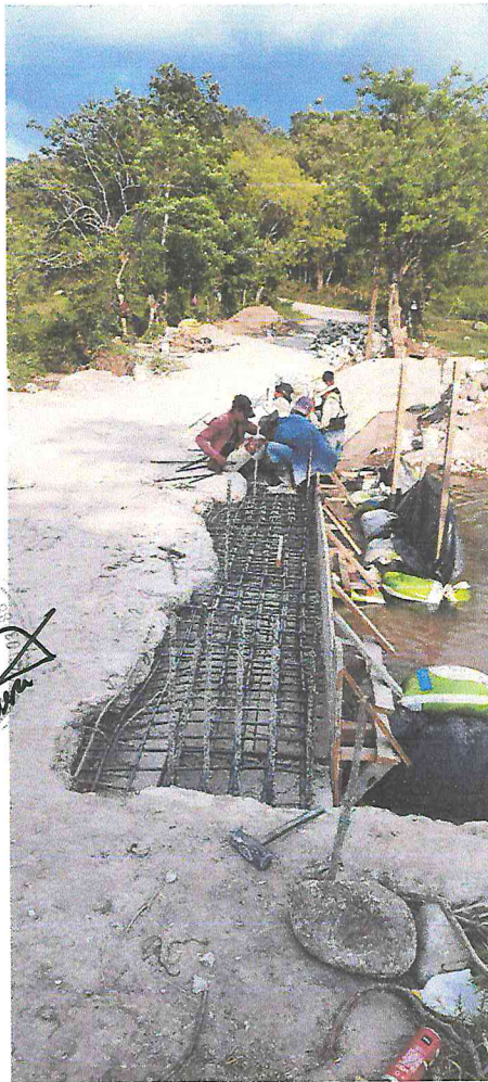
Durante la colocación del armado de refuerzo de la losa superior – caja puente – carretera hacia San Pablo del Roble.
