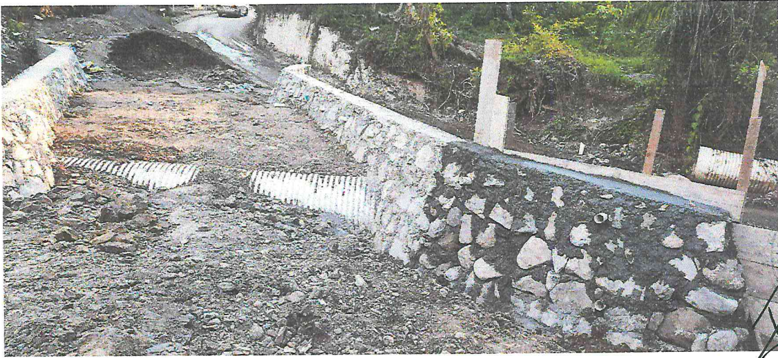
Durante la construcción de las alas en el muro de pie, se prosigue con la colocación del material selecto compactado - vado mixto sobre la quebrada Santa Luz
