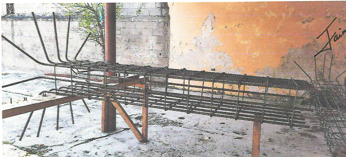
Armado de columnas para el reforzamiento de la caja puente sobre la quebrada Saisoque.
