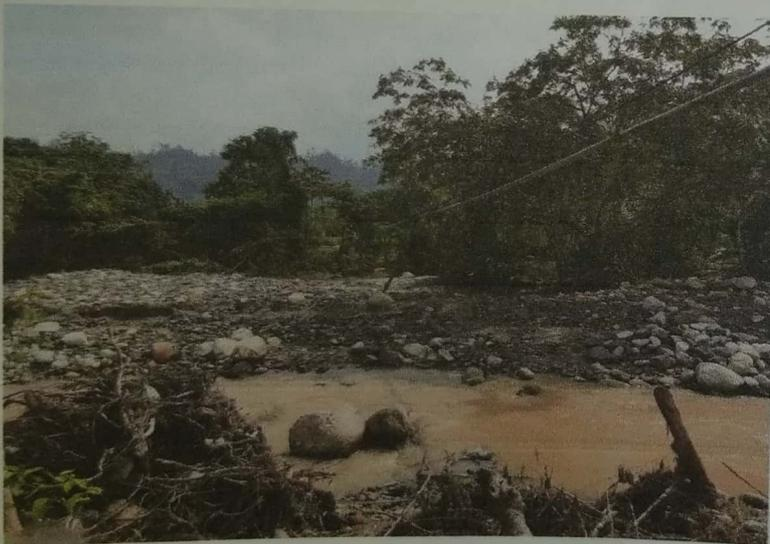
aquí solo apreciamos la Tuberia en el cruce aéreo, sostenida en el cable acerado de  $\frac{3}{4}$ " , instalada con una altura de 4.0 metros, la crecida provocada por ETA y IOTA dejo un cauce de más de 100 m de ancho que en su mayor área se encuentra seco.
