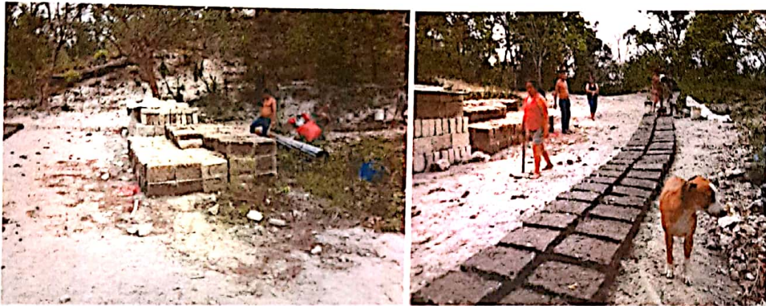
daño y lluvia.
