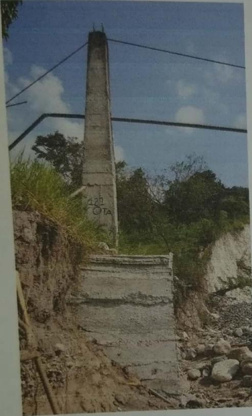
Esta columna tiene una protección de 4.00 metros de longitud frontal y una altura de 2.00 metros con una profundidad de 0.80 metros, al costado derecho visto acá tiene 1.50 metros y al costado izquierdo 1.20 metros, el ancho del muro frontal es de 1.10 metros, en los dos costados tiene 0.60 metros.
