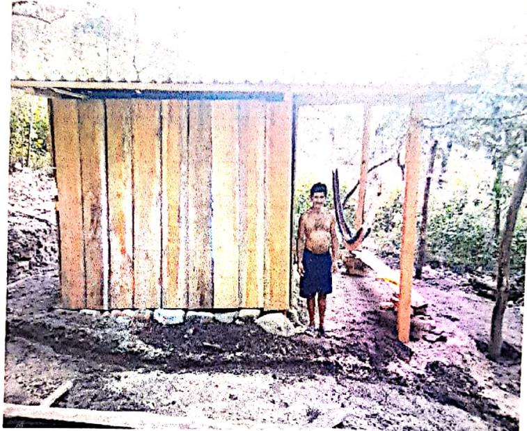
Se realizó la construcción de 1 Vivienda de madera de 5 metros de largo por 3 metros de ancho donde se utilizaron los siguientes Materiales:
