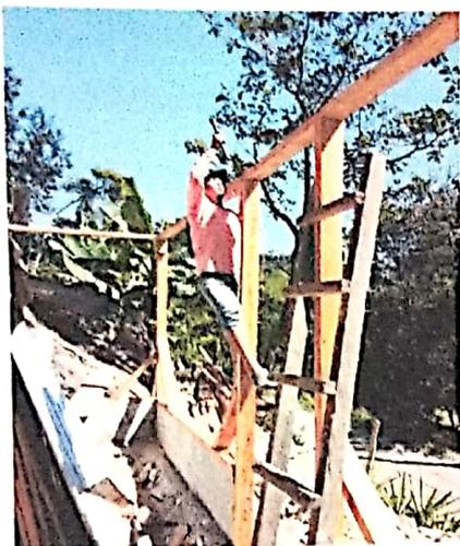
Cortado de madera para conformación de estructura de la vivienda.
