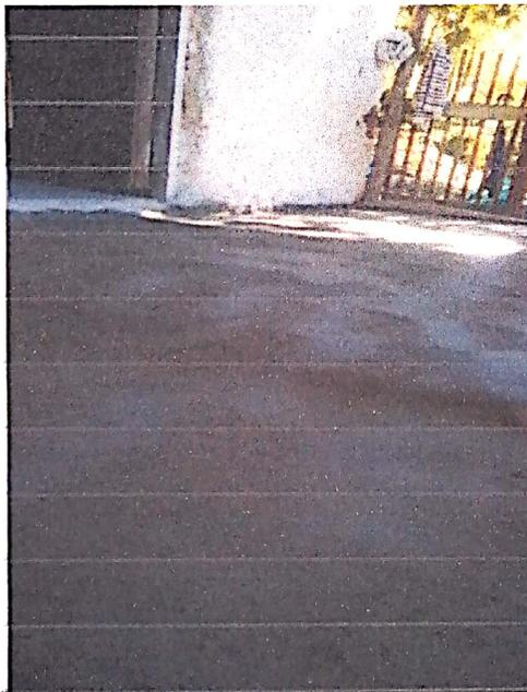
Se fundio concreto simple con un espesor de 4 " (10 cm) en el area de la cocina con un largo de 8 m y un ancho de 3 m con una area total de 24 m<sup>2</sup>. Además de la mano de obra se suministro 5 bolsas de cemento y 0.96 mts<sup>3</sup>. Esto vendra a mejorar la calidad de vida, beneficiando a 6 integrantes de esta familia.
