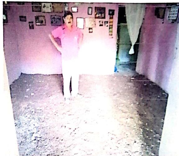
Se fundio concreto simple con un espesor de 4 " (10 cm) en el area de la vivienda con un largo de 10 m y un ancho de 4 m con una area total de 40 m<sup>2</sup>. Además de la mano de obra se suministro 10 bolsas de cemento y 2 mts<sup>3</sup>.
