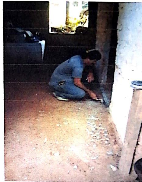
Se fundió concreto simple con un espesor de 4" (10 cm) en el área de la cocina con un largo de 5.8 m y un ancho de 3 m con una área total de 17.4 m<sup>2</sup>. Además de la mano de obra se suministró 7 bolsas de cemento y 1.28 mts<sup>3</sup>. Esto vendrá a mejorar la calidad de vida, beneficiando a 3 integrantes de esta familia.
