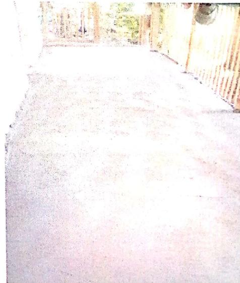
Se fundio concreto simple con un espesor de 4 " (10 cm) en el area del pasillo con un largo de 7 m y un ancho de 1.9 m con una area total de 13.3 m<sup>2</sup>. Además de la mano de obra se suministro 7 bolsas de cemento y 1.44 mts<sup>3</sup>. Esto vendra a mejorar la calidad de vida, beneficiando a 2 integrantes de esta familia (ambos tercera edad).
