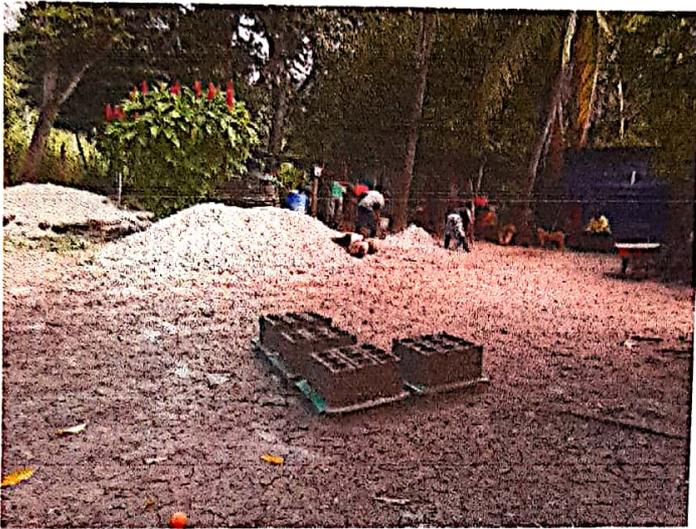
Construcción de bloque, este proceso se lleva a cabo una vez que esta lista la mezcla, estos son armados con maquina eléctrica misma genera compresión a la mezcla en el molde de acero luego estos son retirados y exponerlos bajo el sol para que se sequen y aplicar agua bajo para afinamiento del material (cemento)
