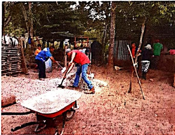
Preparación de mezcla para la fabricación de bloque de 5 pulgadas, esta se realiza con arena gruesa y poca agua.
