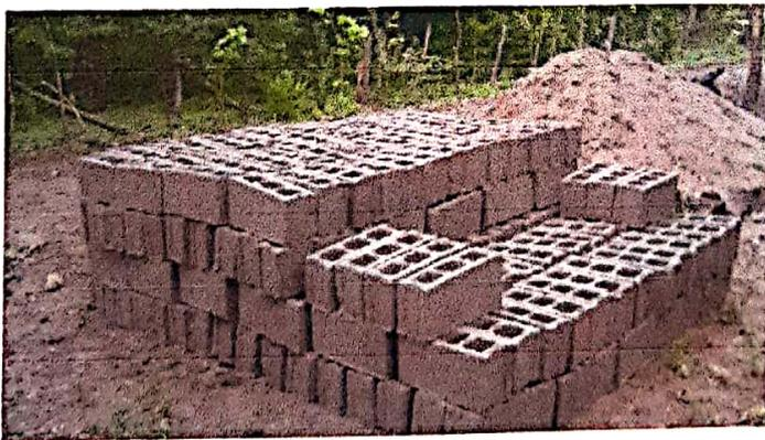
Se realizó la estibación de bloques para aplicación de agua y de esta manera lograr el afinamiento de los mismos.
