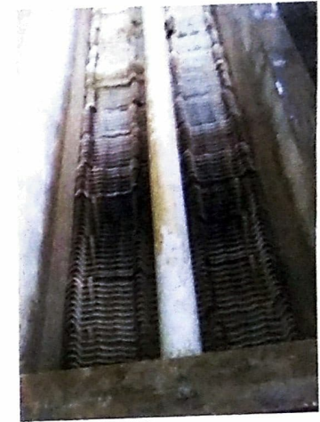
Limpeza de sedimentador
