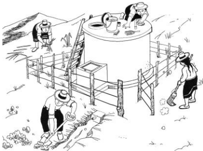
Limpieza externa del tanque
