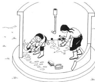
Limpieza y desinfección interna del tanque
