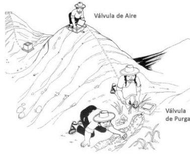
Limpieza y desinfección válvulas de aire y de purga
