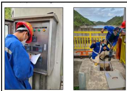
Ilustración 1: Personal del Contratista realizando revisión de los instrumentos de lectura del nivel del Embalse
