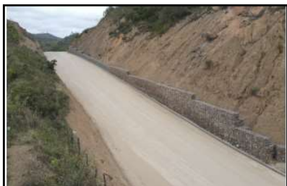
Ilustración 3: Carretera de Libramiento
