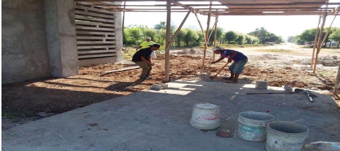
No 3.- Colado de concreto hidráulico en portales
