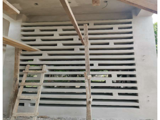
No 2.- Tallado de elementos en pared perforada
