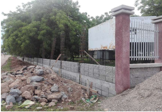
No 1.- Sector "D" del muro perimetral
