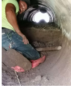
Trabajos de limpieza de tubería para intalacion de tubería, carretera principal.
