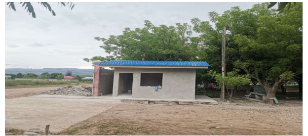
No 4.- Avance en caseta de vigilancia
