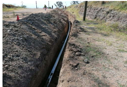
Colocaion de tubería en línea de conducción de agua.
