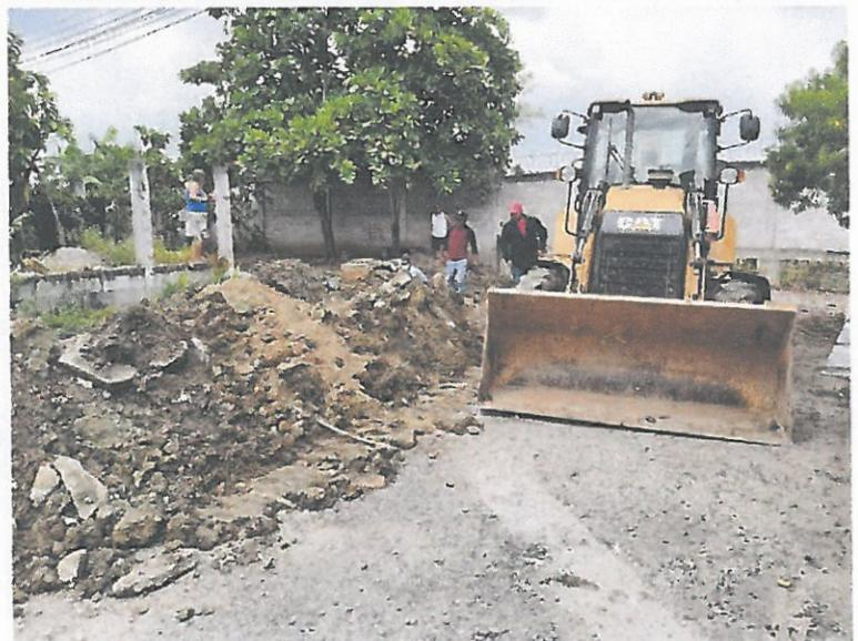
Inician trabajos de excavación y topografía para la construcción de enchapado de cunetas y cajas de paso en la Colonia Villa Real por parte de la Municipalidad.
