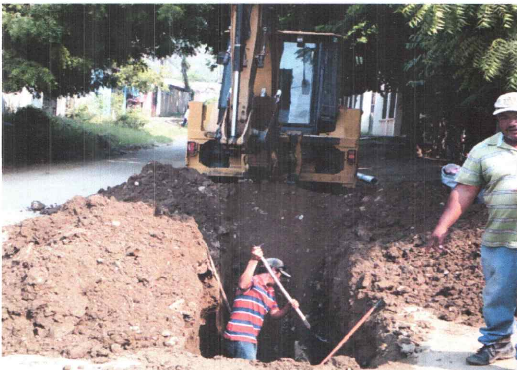
11. Reparar tubo de 6" en Bo. El Obelisco.
