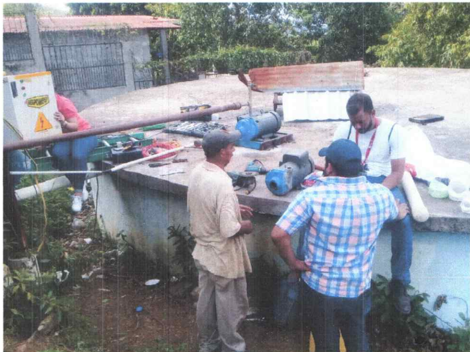
19. Electromecanica en desmontaje e instalación de equipo de bombeo en Tanque Las Lomas, Col. Miguel Yanez.
