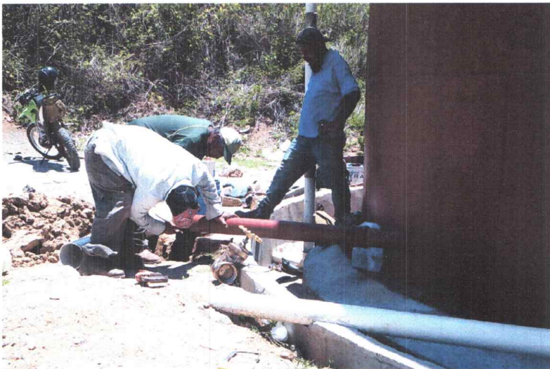
10. Instalación de válvula de 4" en Col. Orquídeas I, II y III.
