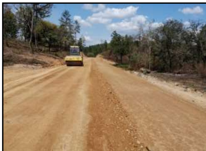
Ilustración 4: Afinamiento de material selecto para capa de rodadura
