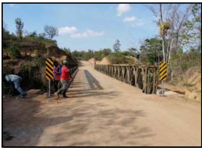
Ilustración 3: Instalación señales verticales en puente Bailey
