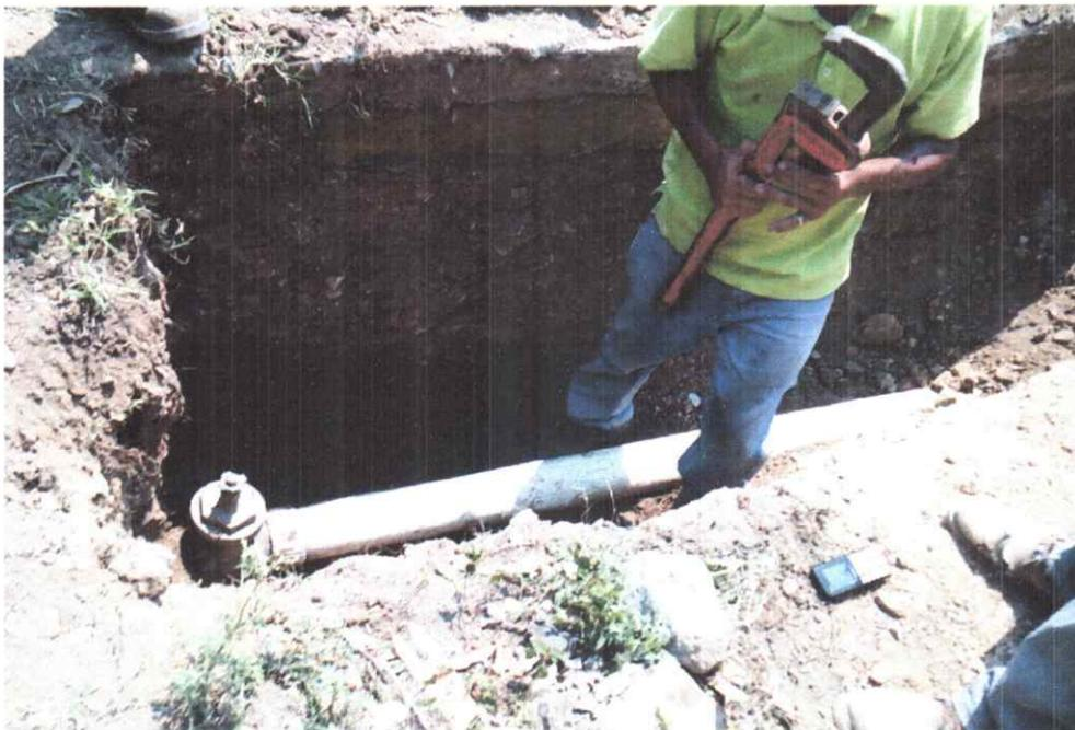
6. Cambio de válvulas de 4" y 6" en descarga de Colinas de Suiza.
