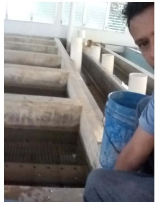
Limpieza de sedimentador
