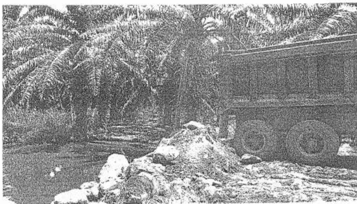
Estabilización de socavón con roca
