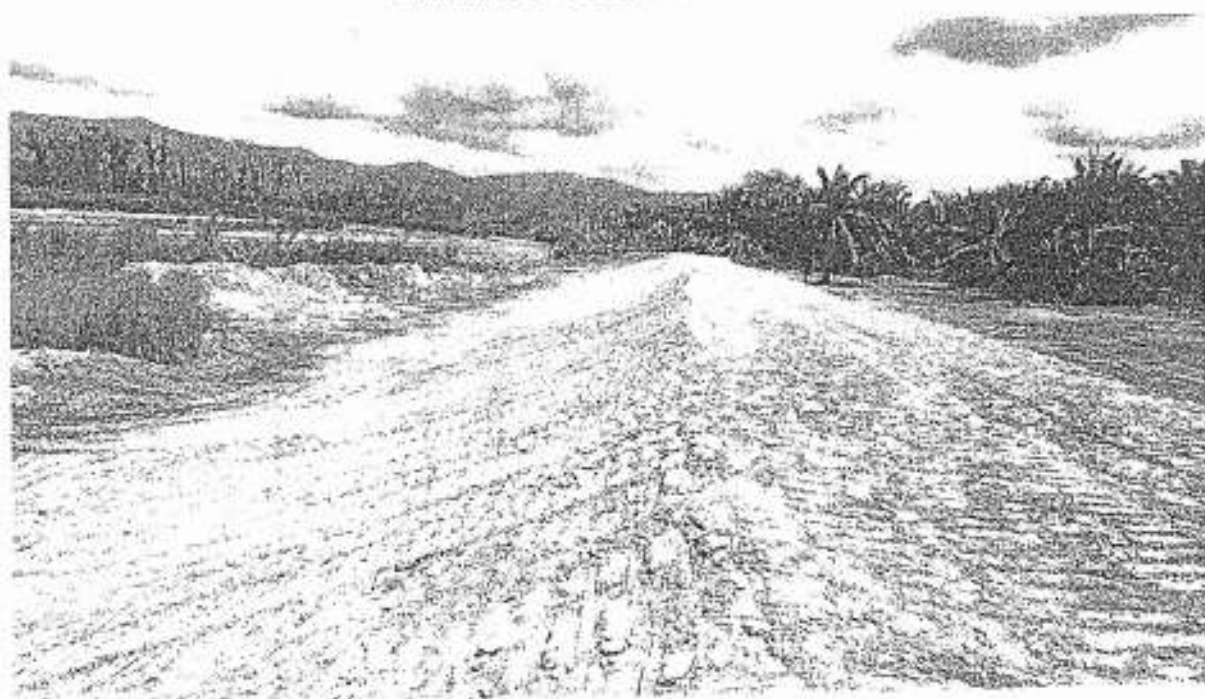
Tramo terminado en cooperativa la cristiana
