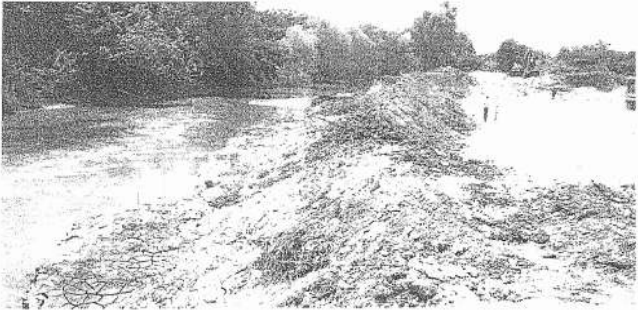
Trabajo en Estabilización de Falla 7
