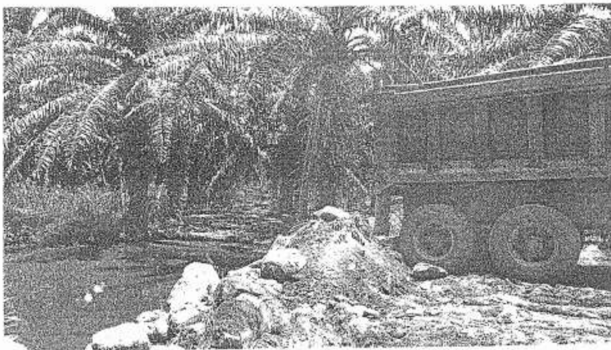
Estabilización de socavón con roca
