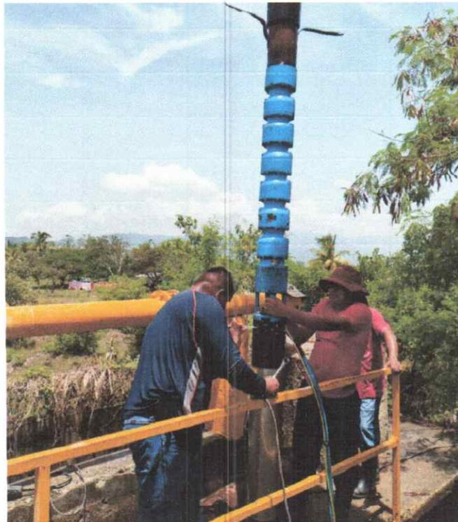
16. Electromecánica en extracción de equipo de bombeo por baja producción de agua e instalación con nueva bomba en Estación de Bombeo Terraplén II.
