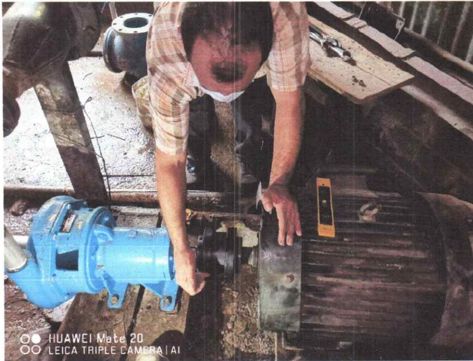
15. Electromecánica en extracción e Instalación de equipo sumergible de 100 HP en Pozo Colinas de Suiza.
