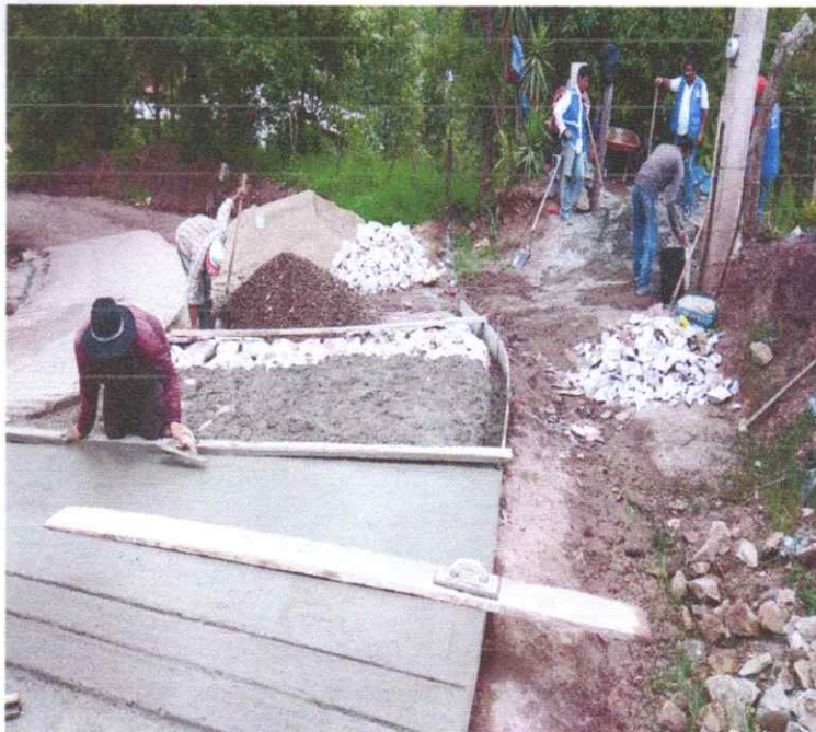
Fundición de calle y cuneta Montaña Grande, Segunda etapa
