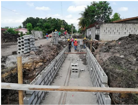
“Canalización de aguas pluviales para reducción del riesgo en Barrio Municipal del municipio de Santa Rita, Departamento de Yoro”
