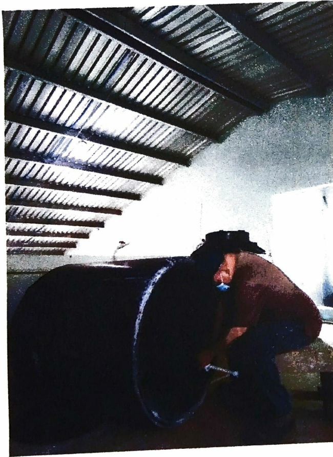
Instalación de Niples en salida de Tanque
