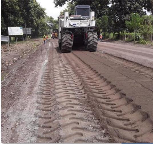
En el periodo actual se están realizando actividades de Limpieza del derecho de vía, Base estabilizada con cemento, Suministro y colocación de base granular, Drenaje menor.
