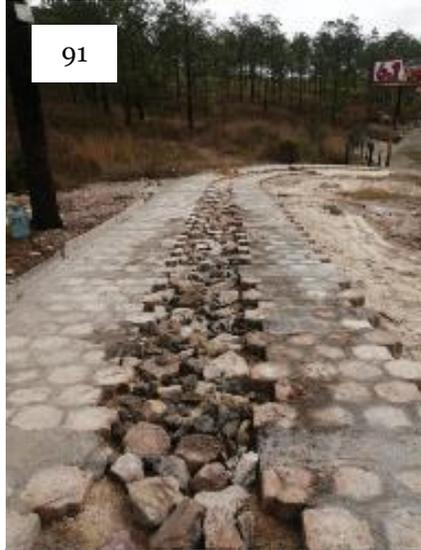
**Ilustración 87:** Personal del Depto. de Caminos por Mano de Obra, realizando trabajos de colocación de adoquines.
