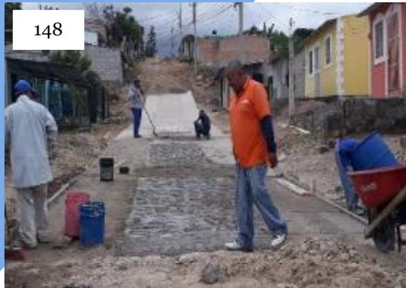
**Ilustración 144:** Personal del Depto. de Caminos por Mano de Obra, realizando trabajos de colocación de piedra y fraguado de área empedrada.
