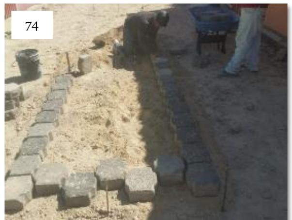
**Ilustración 69:** Personal del Depto. de Caminos por Mano de Obra realizando trabajos de colocación y compactado de material selecto sobre la calle del sector 9, peatonal I-4 de la Col. Divina Providencia.
