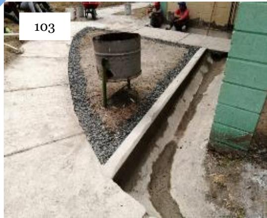
**Ilustración 97:** Personal del Depto. de Caminos por Mano de Obra, realizando trabajos de excavación y limpieza en área de acceso hacia módulo de aprendizaje que será mejorada.
