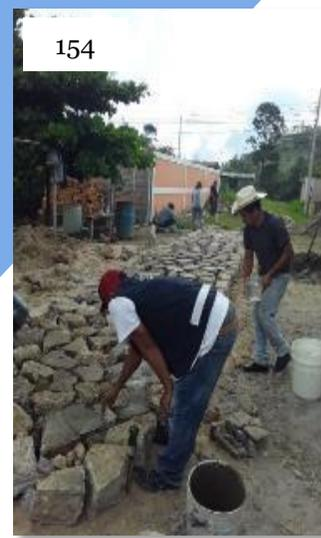
**Ilustración 149:** Personal del Depto. de Caminos por Mano de Obra, realizando trabajos de descarga de pequeñas secciones de losa de concreto que previamente fueron cortados a mano, para utilizarlas sobre la calle del sector 1 de la Col. Campo Verde.
