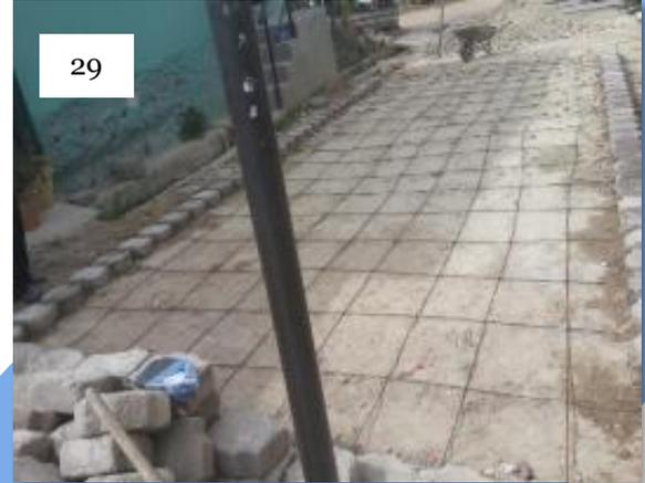
**Ilustración 24:** Personal del Depto. de Caminos por Mano de Obra realizando trabajos de preparación de área que será adoquinada y colocación de material selecto.
