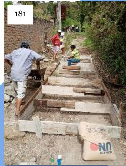
**Ilustración 178:** Panorámica de los trabajos de construcción de la I etapa de una (1) sección de gradas, en calle de acceso hacia
