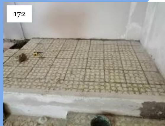
**Ilustración 167:** Personal del Depto. de Caminos por Mano de Obra, realizando trabajos de colocación de piezas de mosaico.
