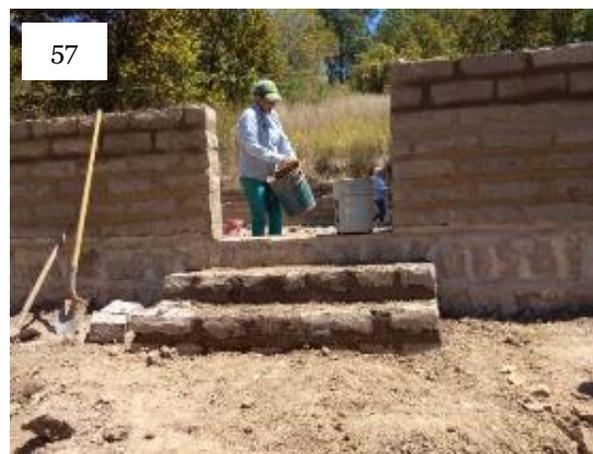
**Ilustración 52:** Personal del Depto. de Caminos por Mano de Obra, realizando trabajos de colocación y pegado de adobes.
