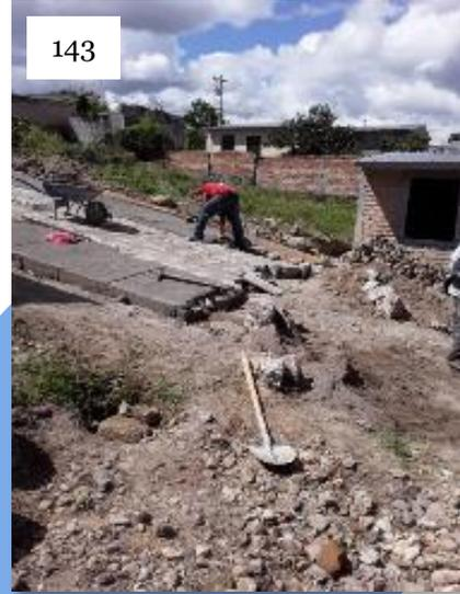
**Ilustración 138:** Personal del Depto. de Caminos por Mano de Obra, realizando trabajos de colocación de piedra.
