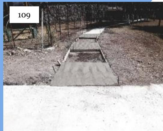
**Ilustración 104:** Personal del Depto. de Caminos por Mano de Obra, realizando trabajos de codaleado en acera fundida.
