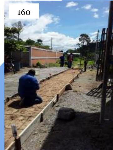
**Ilustración 155:** Panorámica de los trabajos de colocación de pequeñas secciones de losa de concreto cortadas a mano, para utilizarlas sobre la calle del sector 1 de la Col. Campo Verde.
