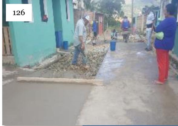
**Ilustración 122:** Personal del Depto. de Caminos por Mano de Obra, realizando trabajos de colocación de piedra.
