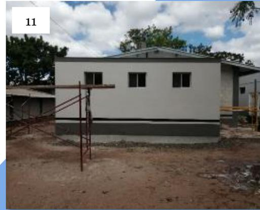
**Ilustración 110:** Finalización de los trabajos de instalación de prefabricados, cimentación y construcción liviana de paneles en seco, en la que participó personal del Depto. de Caminos por Mano de Obra, en las Instalaciones de INFOP Miraflores.
