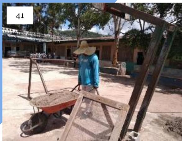
**Ilustración 36:** Personal del Depto. de Caminos por Mano de Obra realizando trabajos de preparación de mortero de cemento.
