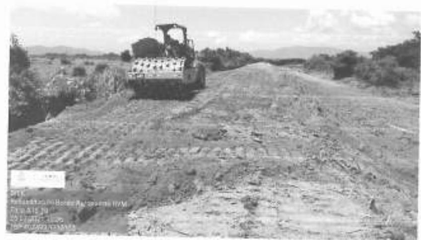
Avance físico Julio 2021 proyecto: Rehabilitación de tramos de bordo perimetral de aeropuerto Ramón Villeda Morales.
