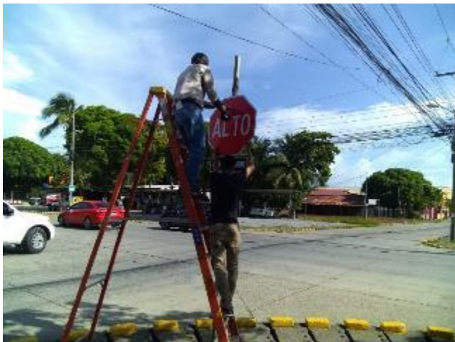
Instalación Señal de Alto B. Copen 13 calle esquina de la 3 avenida
