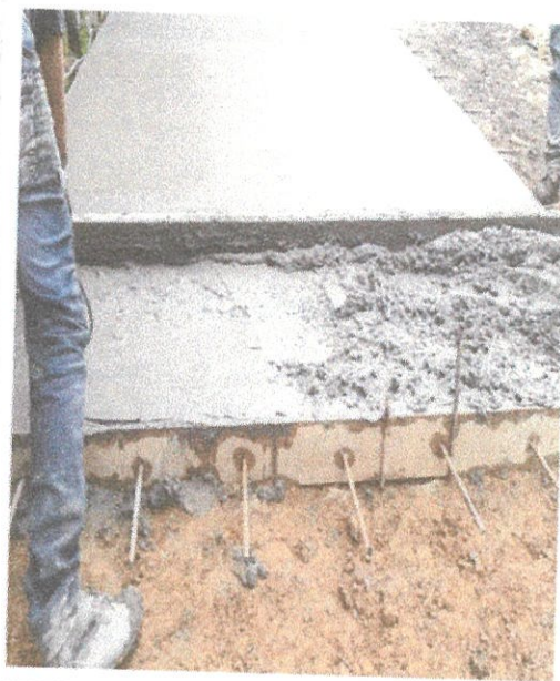
Vista de tramo casi terminado con sus barras pasa juntas y barras de amarre colocadas
