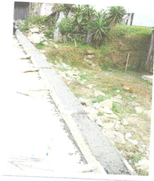
Encofrado y fundición de bordillo con concreto 1:2:2
