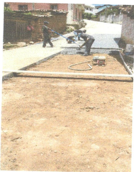
Fundición de tramo casi al final de la obra
