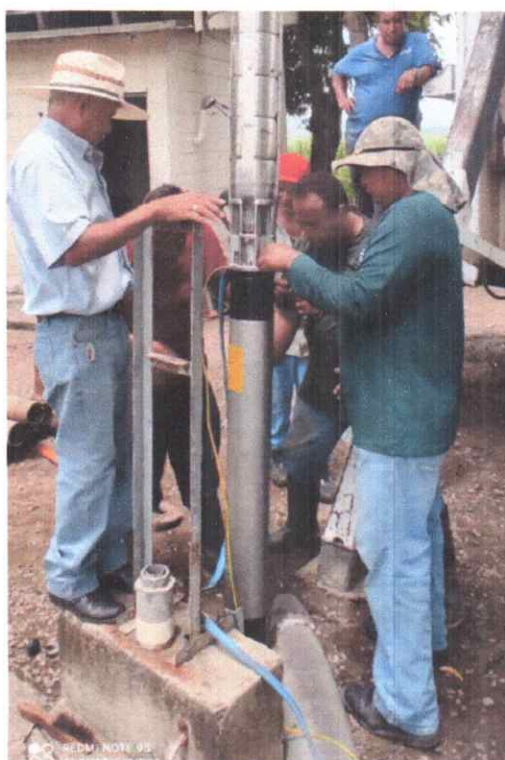
20. Electromecánica en instalación de equipo de bombeo de 60 HP en el Pozo # 3 Zona Cañera.
