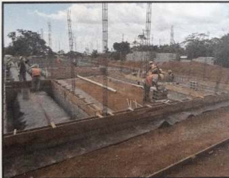
Ilustración 4. SE ESTA COLOCANDO EN BLOQUE EN LA OBRA
