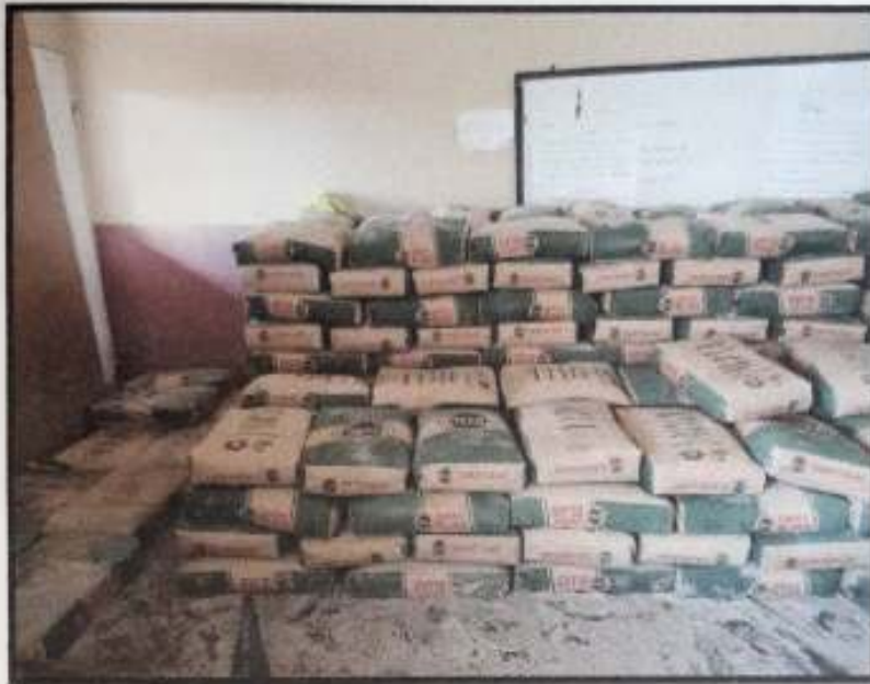
Ilustración 3. CEMENTO EN SITIO DE LA OBRA
