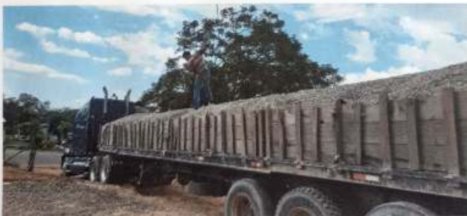
3. Se compra grava, la cual se descargó en el colegio
