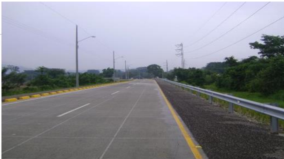
Km 13+600, Inicio Lote I. Se observa el hombro con DTS y el bordillo intermitente.
