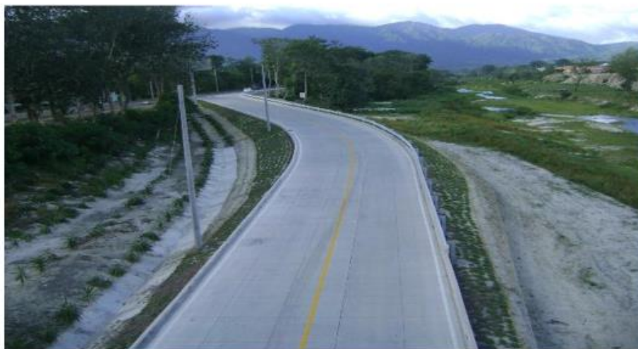
Paso desnivel Río Blanco. Toma desde el puente, salida a Interconector Bordo Río Blanco - Biv. Norte
