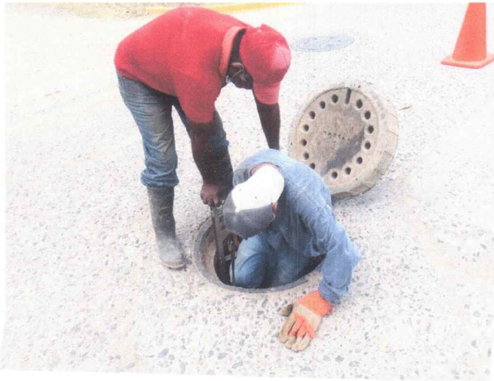
21. Alcantarillado Sanitario limpieza de cajas de registro, holes y conexiones en diferentes lugares del municipio.
