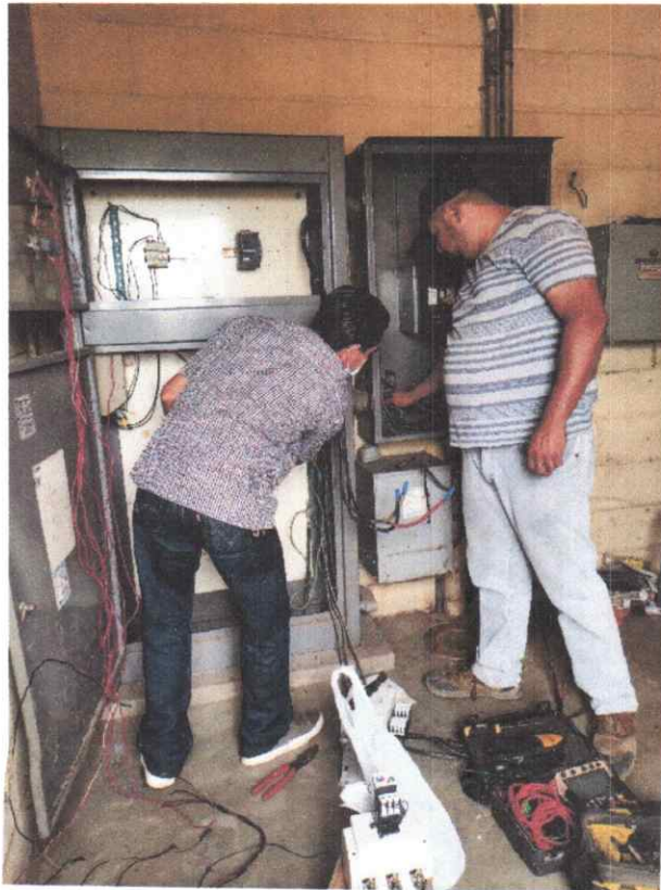
20. Electromecánica instalación de motor y bomba 75HP/ 460V/ 3PH y armado de gabinete con Arranque Directo en el Pozo #2 Sector Cañeras.
