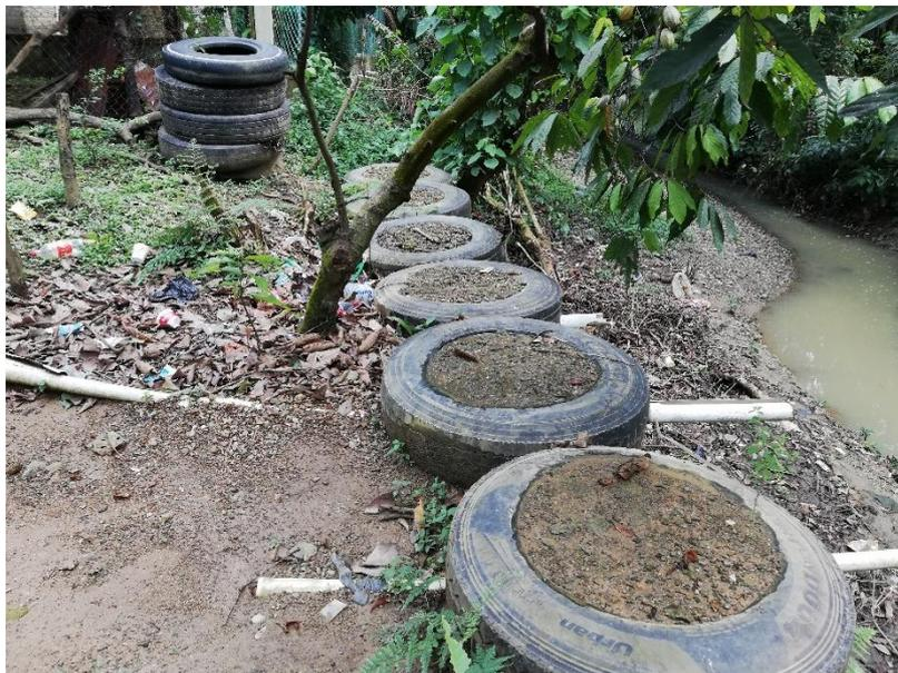
Figura 2: Instalación de Llantas para estabilizar terreno
