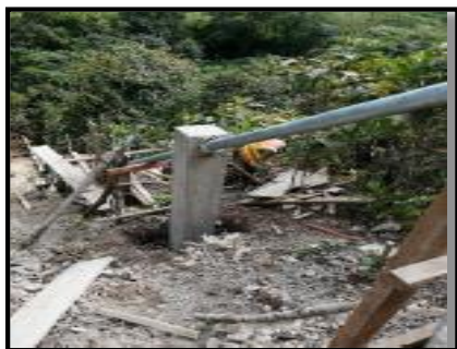
Ilustración 4: Instalación de Tubería de HG para dotación de agua potable
