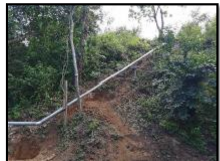
Ilustración 4: Instalación de Tubería de HG para dotación de agua potable
