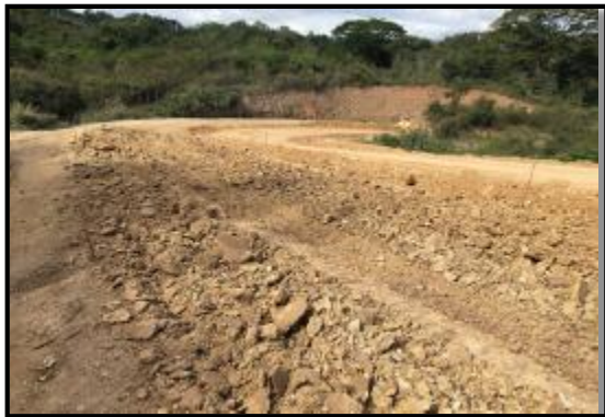
Ilustración 2: Afinamiento de la Capa de Rodadura
