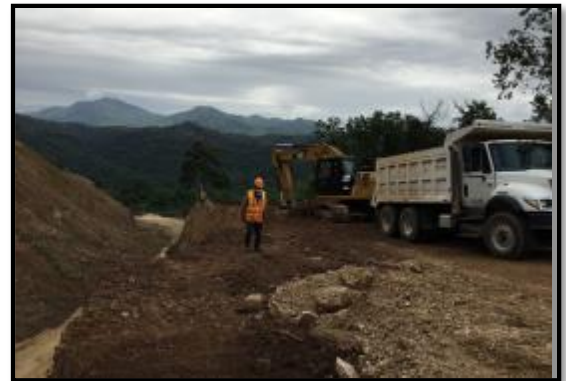
Ilustración 3: Corte de talud y conformación de bermas
