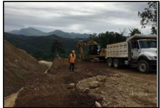
*Ilustración 3: Corte de talud y conformación de bermas*
