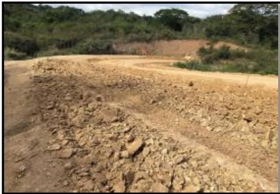
*Ilustración 2: Afinamiento de la Capa de Rodadura*
