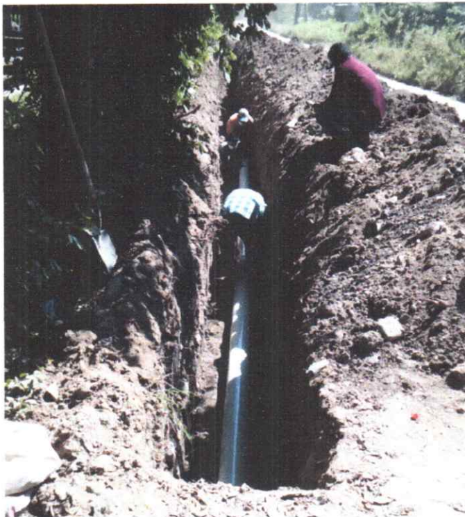
14.Instalación de tubería de nueva red de 6" hacia La Línea.
