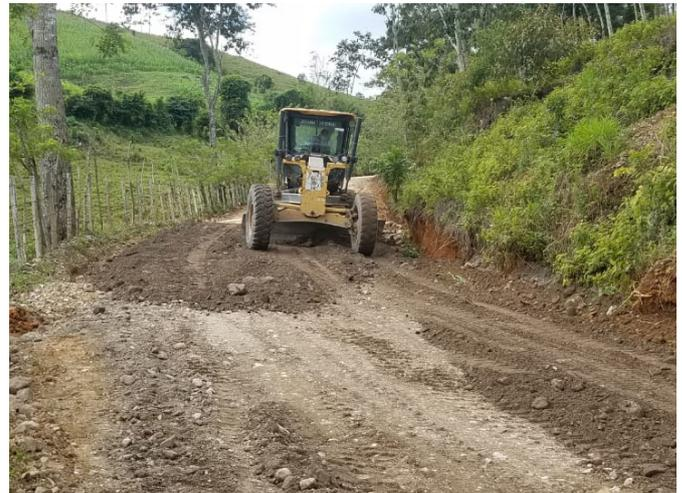
recuperación de calzada, estabilización de zonas inestables y mejoramiento de rodadura.
