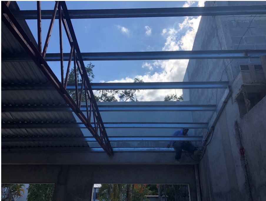
Imagen 5. Instalación de techo y cerchas metálicas – Módulo I
