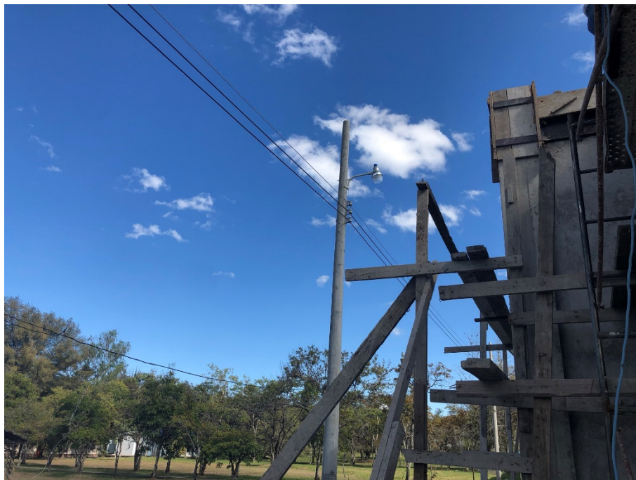
Imagen 8. Instalación de línea secundaria
