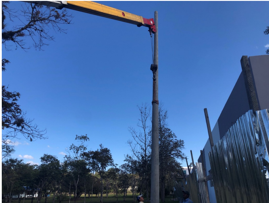
Imagen 6. Instalación de postes de concreto
