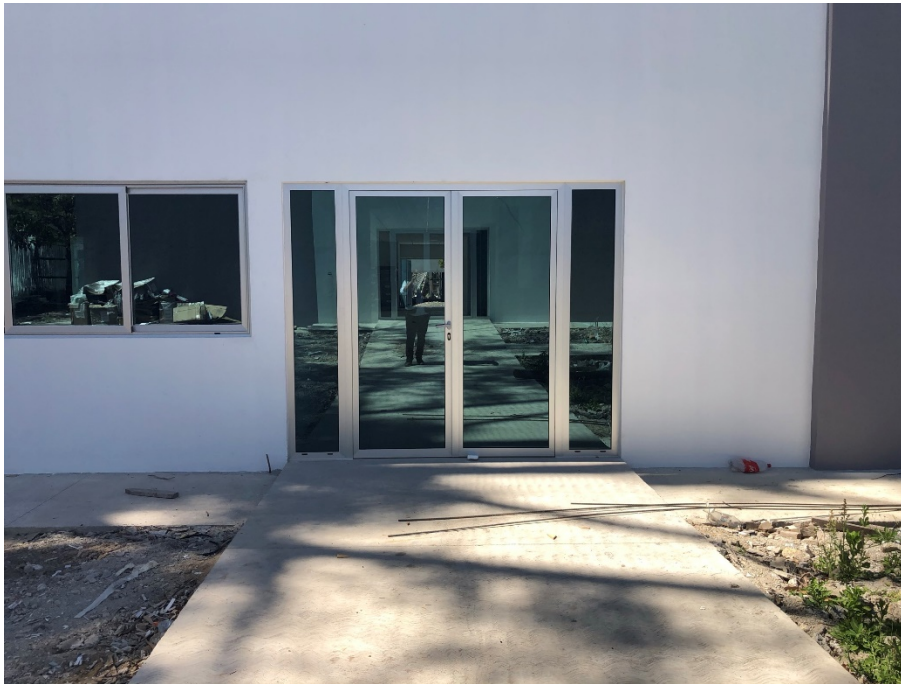
Imagen 1. Instalación de Puertas de Vidrio Dobles – Módulo II
