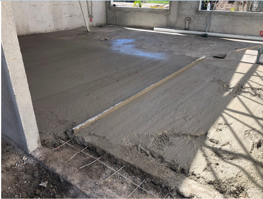
Imagen 4. Fundición de Firme de Concreto – Módulo I
