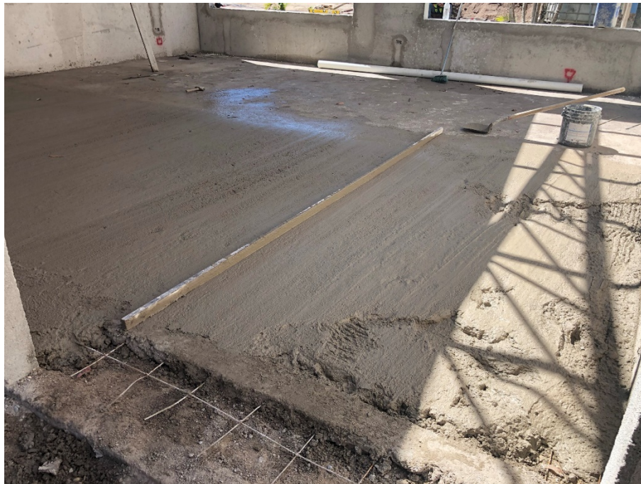
Imagen 3 Fundición de Firme de Concreto – Módulo I
