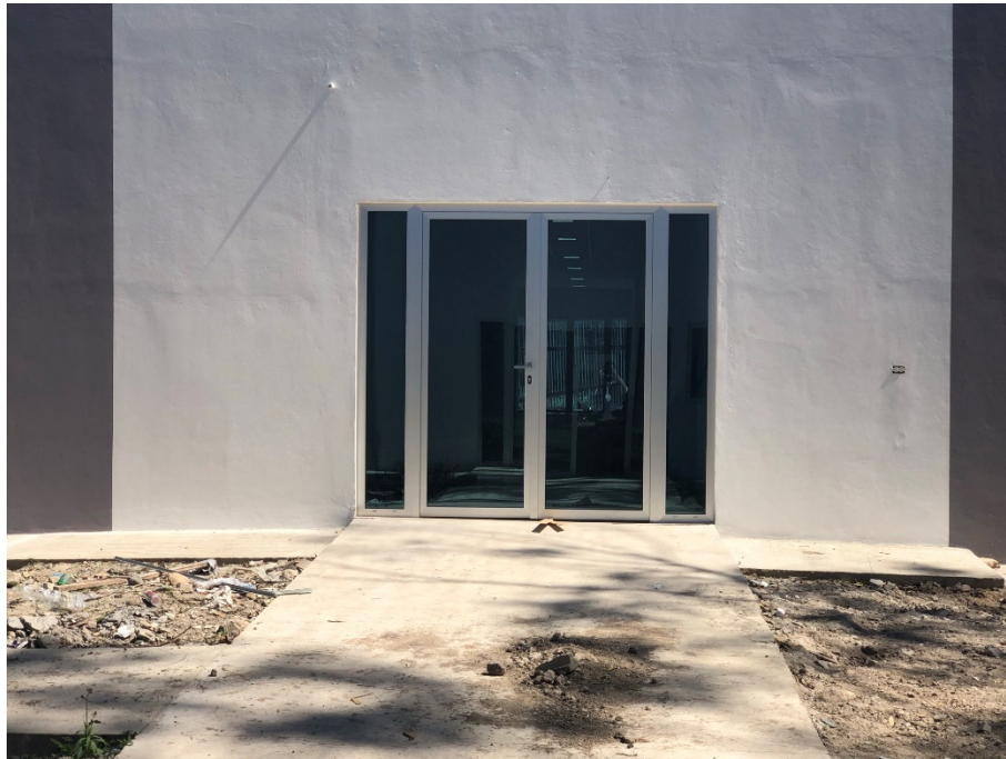
Imagen 2. Instalación de Puertas de Vidrio Dobles – Módulo II
