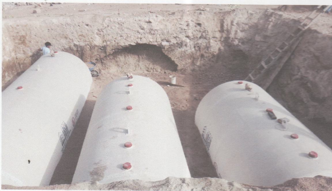
Anexo 6 Inspección de instalación de tanques para almacenamiento de combustible en la gasolinera Mi Arbolito.
