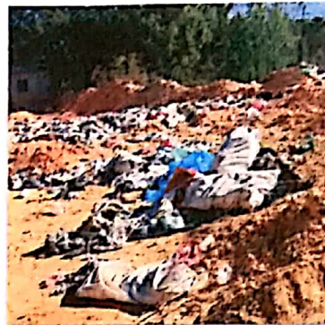
Construccion de borda en crematorio Municipal.
