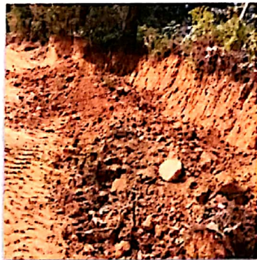
Arrancado de material selcto para cobertura (semanalmente)
