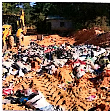
Tapado de residuos solidos con la maquina
