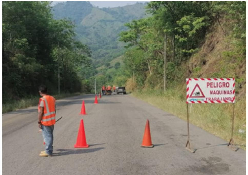
**Las actividades a realizar: un bacheo intensivo y posteriormente un sello a través de la colocación de microcarpetas en las secciones que lo requieran.**
