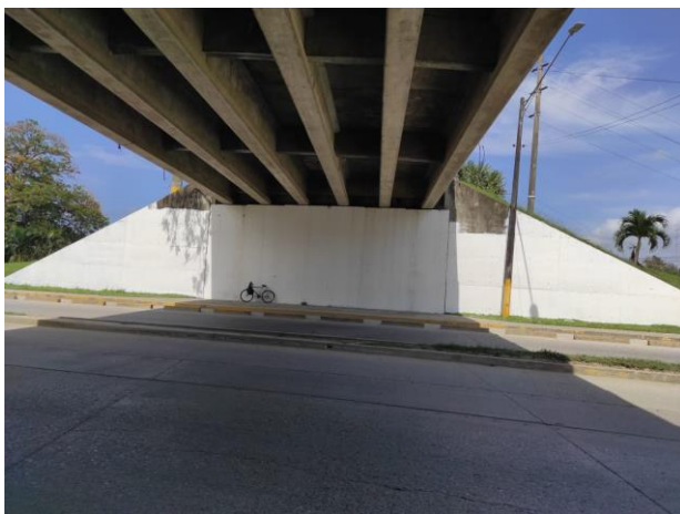
ANTES. Puente Desnivel Bo. Pueblo Nuevo.
