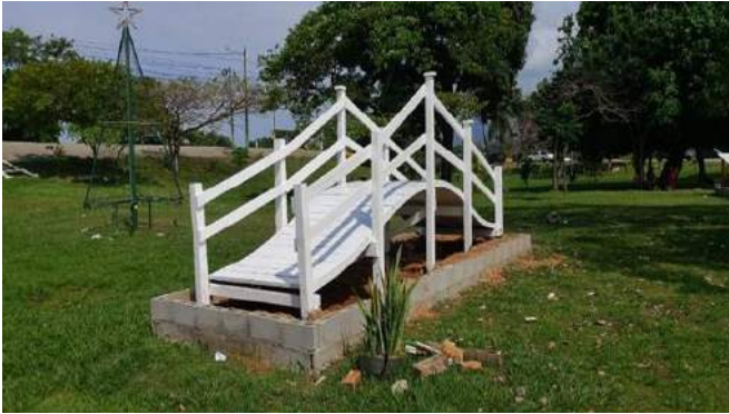
Finalización del Proyecto del Puente de Madera de la Plaza Milenaria.
