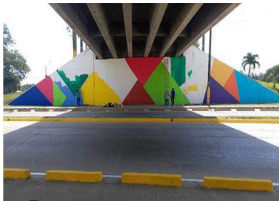
Pintado del puente a desnivel.
