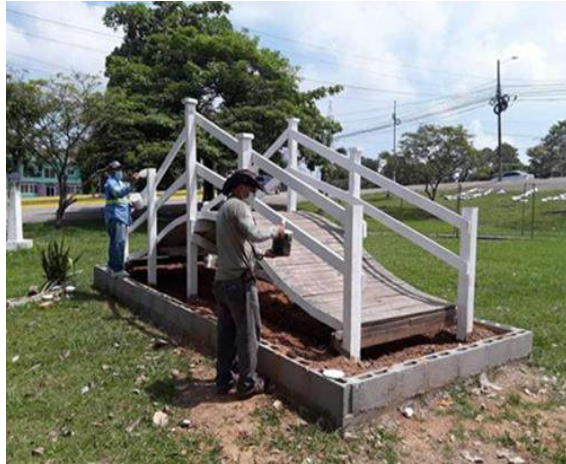
Avance en el Puente de Madera de la Plaza Milenaria.
