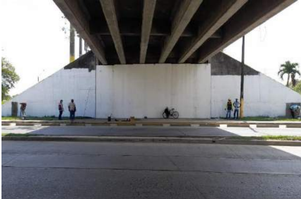
Inspección Puesto de desnivel.
