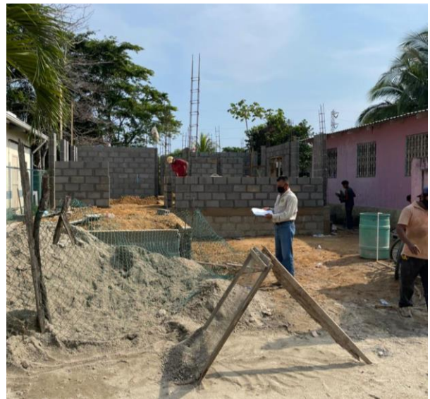
Inspección para otorgar permiso de construcción Bo. Buenos Aires.
