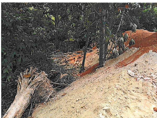
Inspección de plantel en Rio Chiquito.
