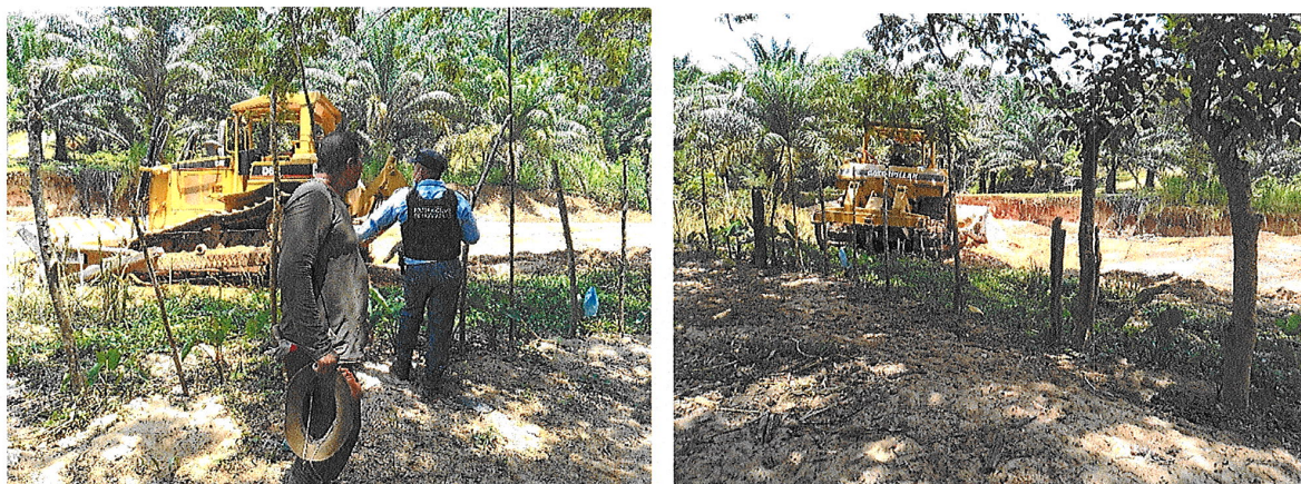
Inspección por desazolvamiento de la quebrada en Rio Chiquito
