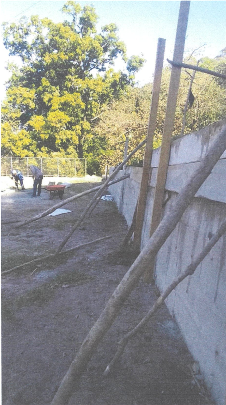
MURO DE CONTENCIÓN EN CANCHA DE FUTBOL EL CARRIZAL
