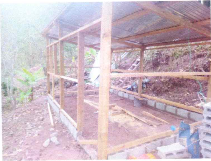
Construcción de casa de láminas
