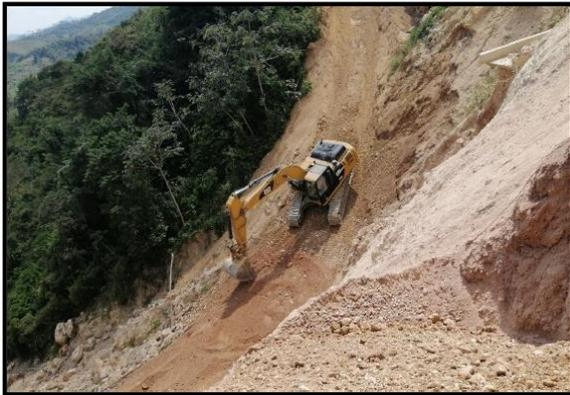
*Ilustración 2: Conformación de rampa*
