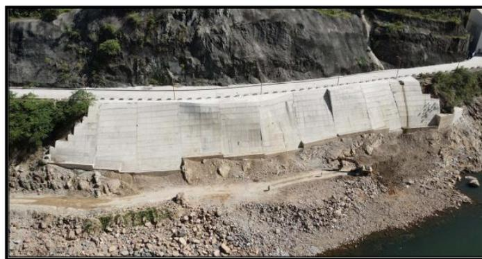
**Ilustración 1:** Muro de protección de talud de la Calle de Acceso a Casa de Máquinas
