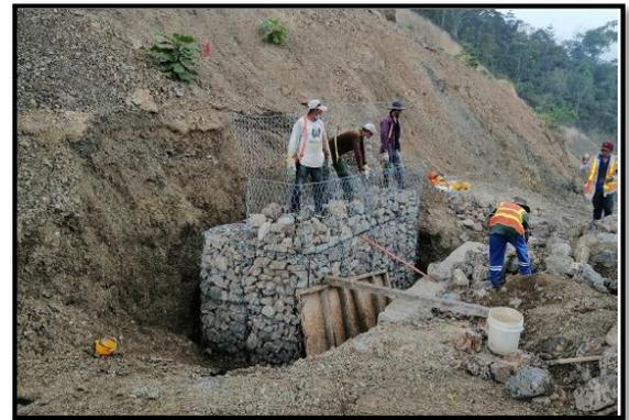
*Ilustración 3: Construcción de gaviones para control de arrastre*
