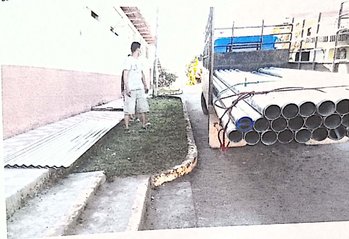
Entrega de tubería para reparación de la línea de conducción del Sistema de agua de la Comunidad de Nuevo Jalapa.
